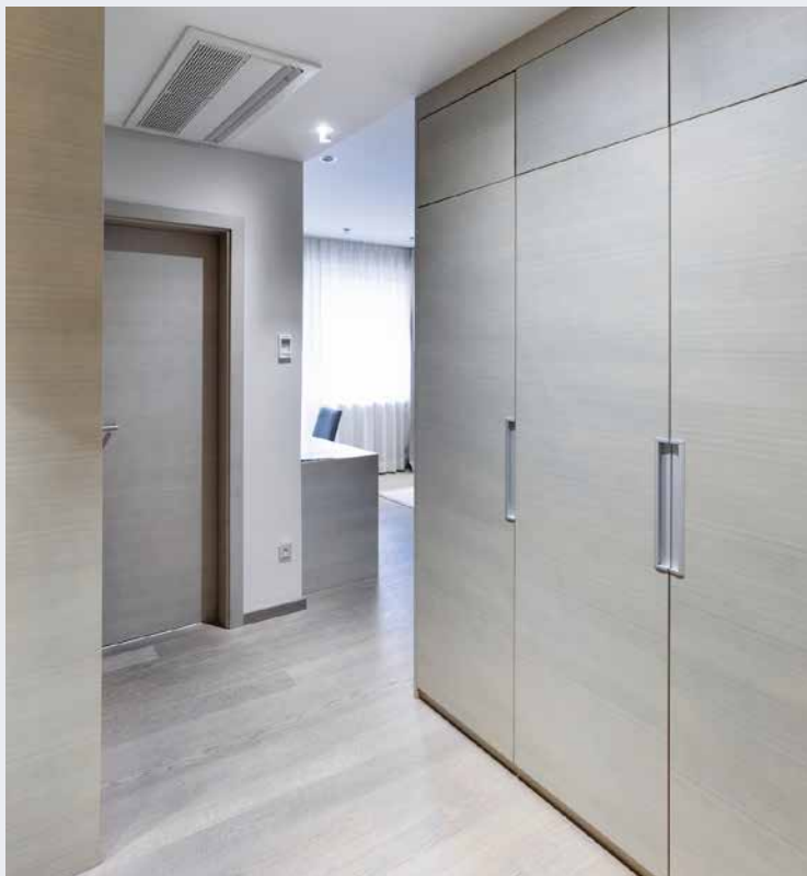
Gesundheitszentrum Park, Igls, Innsbruck, EDMUND SPARER Klima & Kältetechnik GmbH
