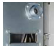
Otvor pro revizi vany kondenzátu
