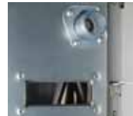
Otvor pro revizi vany kondenzátu
